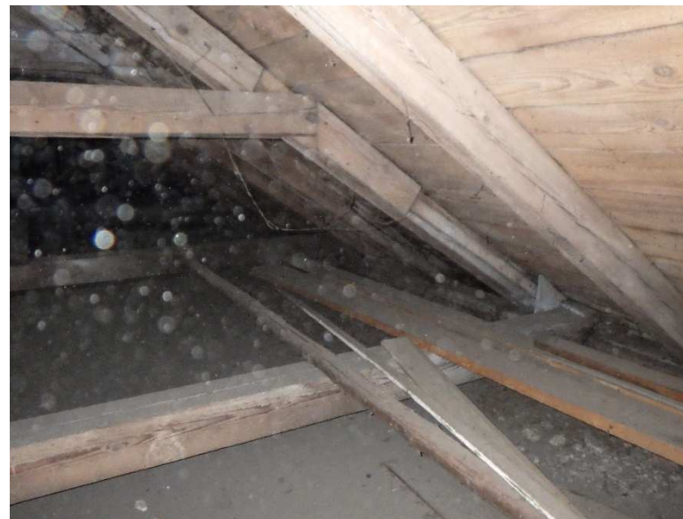
Foto č. 12 - 9-10 DE 2. krokev - neaktivní plodnice hub
