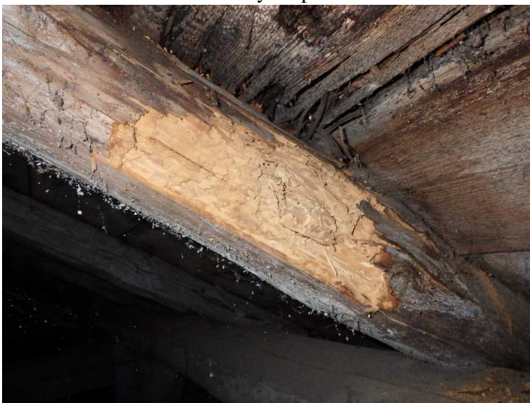
Foto č. 7 - 6-7B 2. krokev - částečný rozpad
