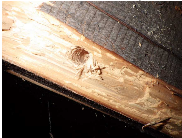
Foto č. 14 - 10-11 AC 2. krokev - neaktivní plodnice hub
