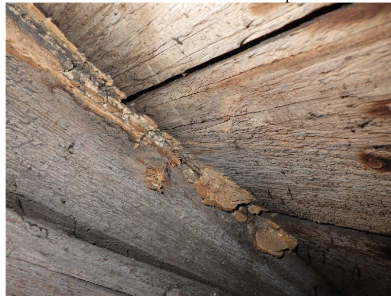
Foto č. 12 - 9-10 DE 2. krokev - neaktivní plodnice hub
