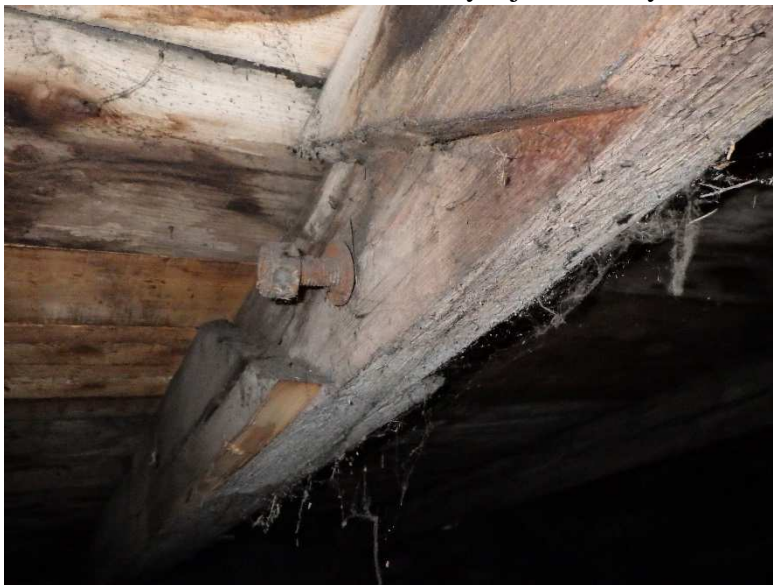
Foto č. 15-16 - 13'-16 EF - rozvolněný spoje hambáleků a krokví
