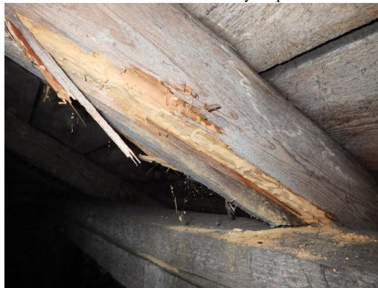
Foto č. 8 - 1-2 AB 2. krokev - částečný rozpad
