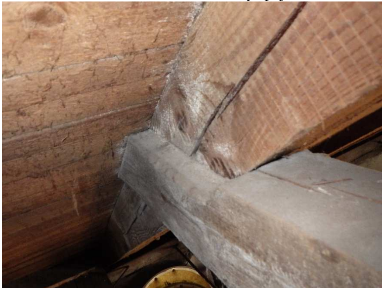
Foto č. 15-16 - 13'-16 EF - rozvolněný spoje hambáleků a krokví
