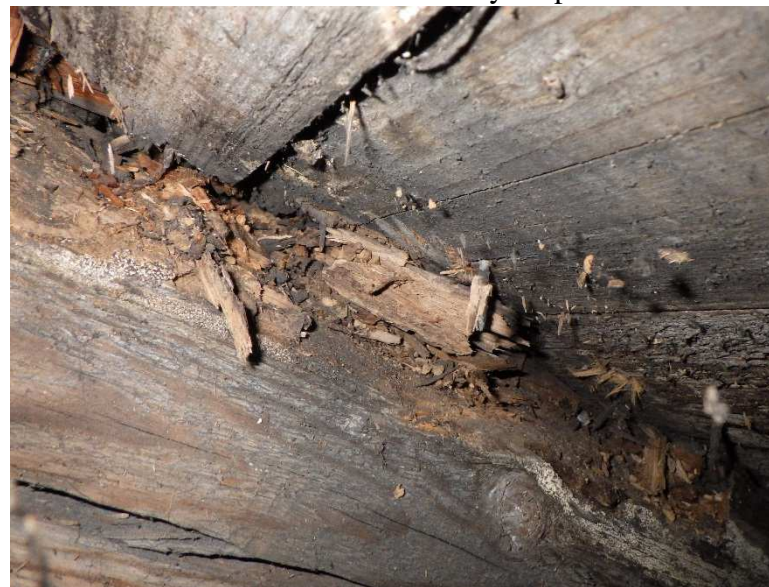
Foto č. 8 - 1-2 AB 2. krokev - částečný rozpad
