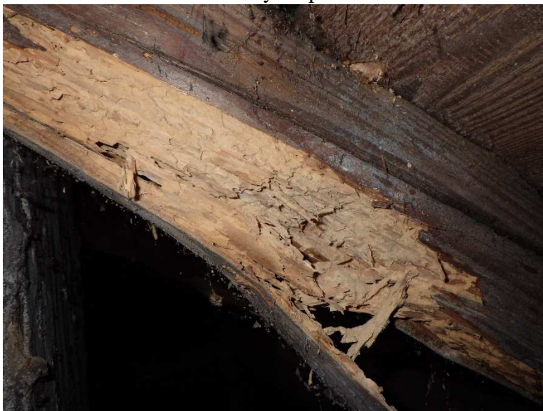
Foto č. 7 - 6-7B 2. krokev - částečný rozpad
